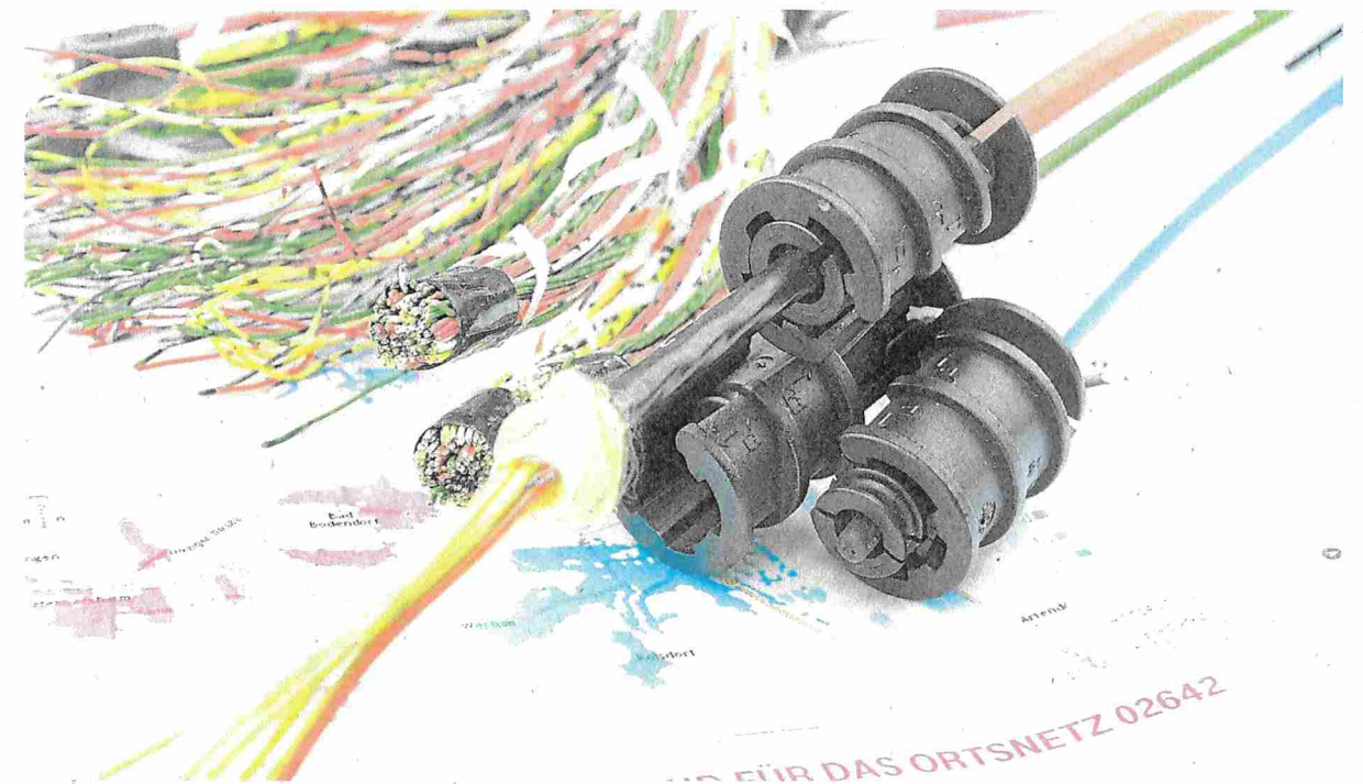
Die Glasfaser wird direkt bis in die Gebäude verlegt.
