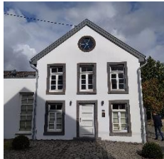
Ehemalige Synagoge (Foto: IPU GmbH)
