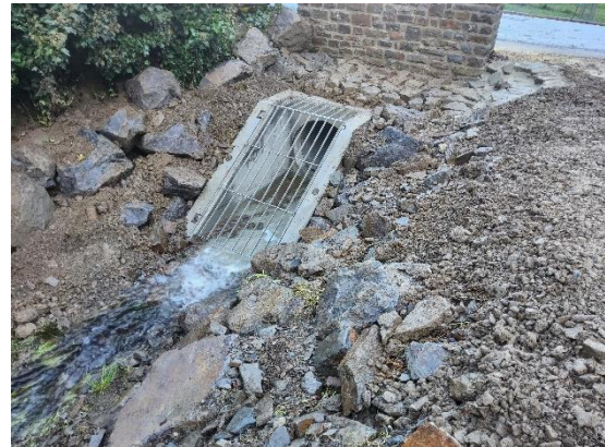
Abbildung 1: Inbetriebnahme des neuen Einlaufbauwerks am Lückenbach, Quelle: Eigene Darstellung 12/23
