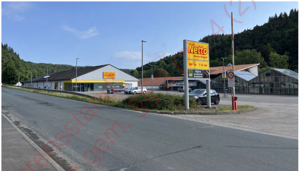
Plangebiet von der B 257, Blickrichtung Norden auf einen Lebensmitteleinzelhändler (Teilgebiet B)
