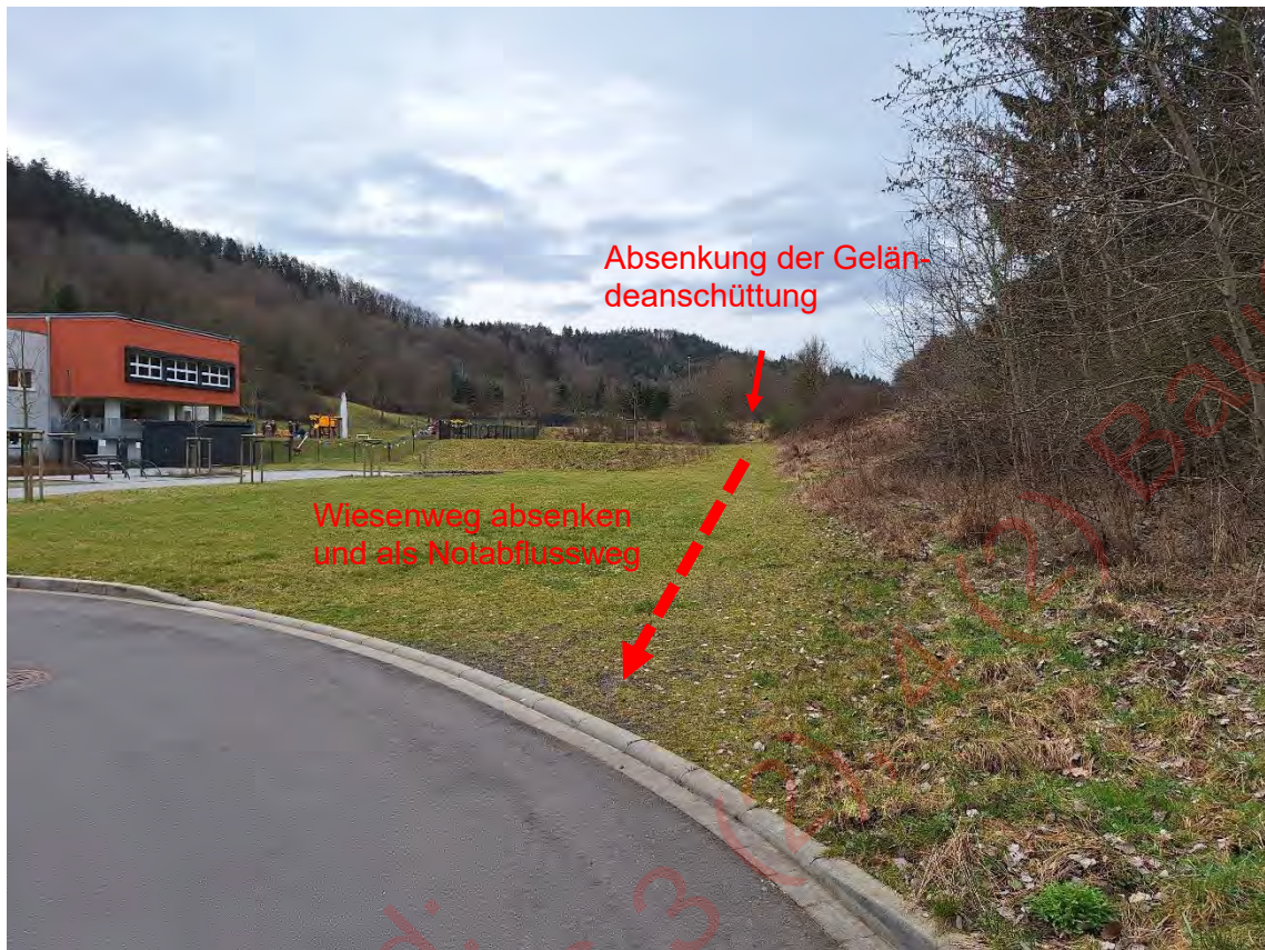
Bild 6: KITA (Blick talaufwärts )
