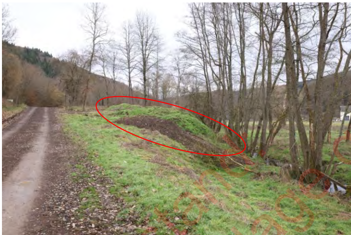
Abbildung 24: Aufschüttung im Bereich des Radweges
