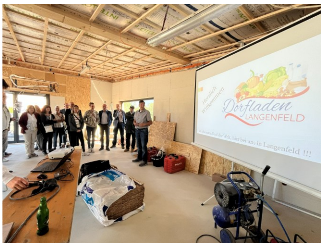
Im entstehenden Dorfladen Langenfeld stellte Ortsbürgermeister Mario Heinrichs das Projekt direkt vor Ort auf der Baustelle vor. (Foto: Theresa Göbel c/o Sweco GmbH)
